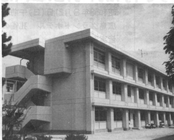
本年度完成の校舎（3号館）
